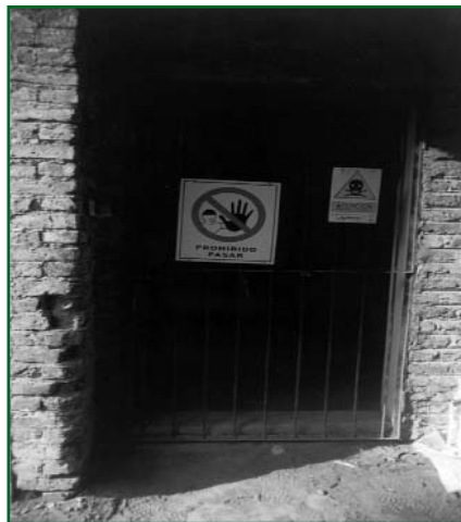
Figura 8 Depósito aislado donde se almacenan plaguicidas ubicado en el Alto Valle de Río Negro y Neuquén
